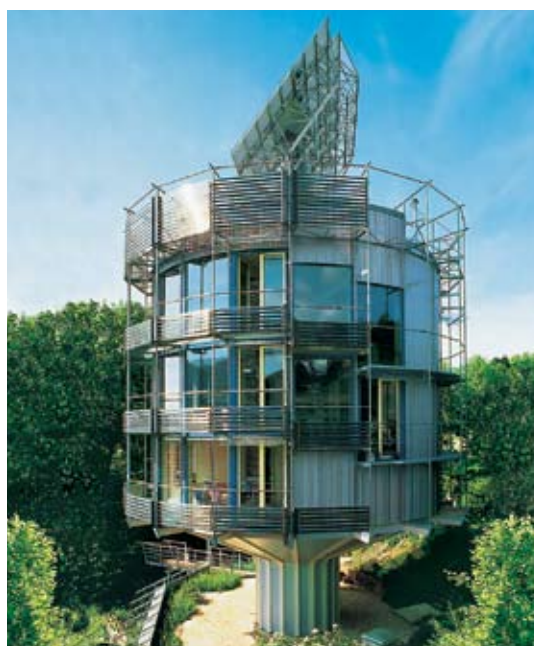
Fot. B.1.7-4 Kolektor próżniowy zamontowany na balustradzie w okrągłym domu w Freiburgu
