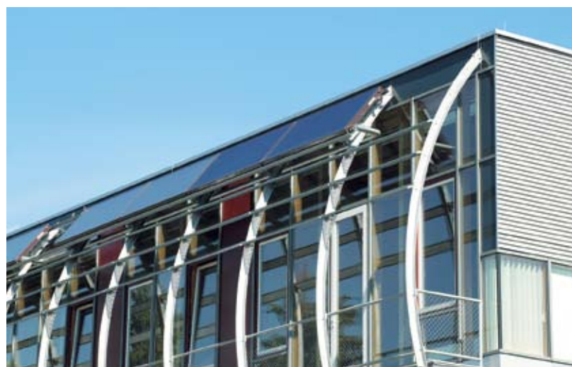
Fot. B.1.7-2 Montaż kolektorów jako roleta, baldachim
