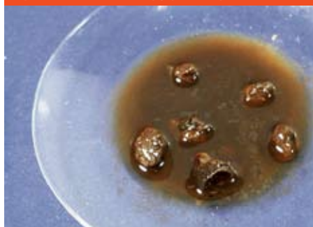
Rys. B.3.4-1 Uszkodzony płyn solarny
