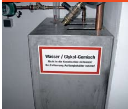
Rys. B.3.5-10 Zbiornik magazynujący
